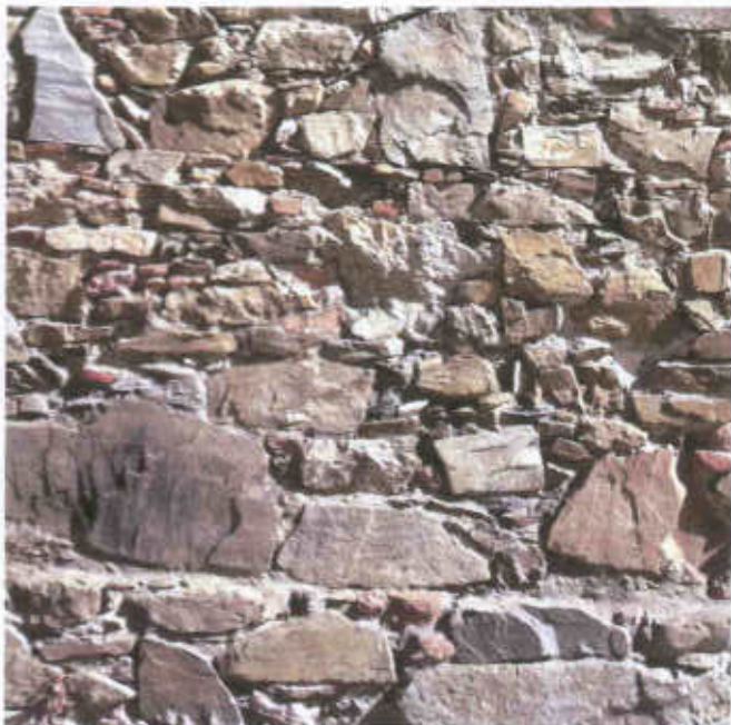
MURATURA IN PIETRA 😊
