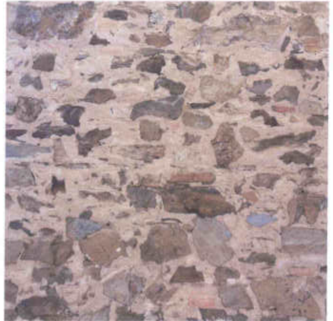
MURATURA IN PIETRA 😊
