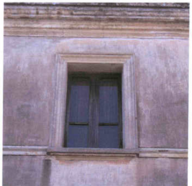
FINESTRA AL PIANO PRIMO 😊
