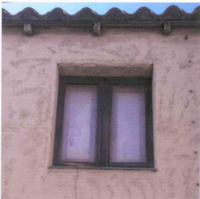
FINESTRA AL PIANO PRIMO 😊
