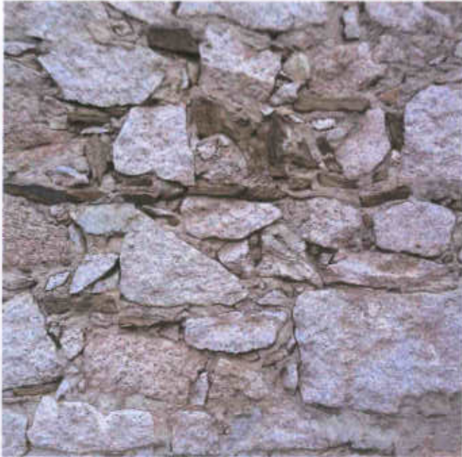
MURATURA IN PIETRA 😊
