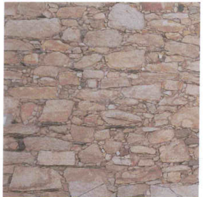
MURATURA IN PIETRA 😊
