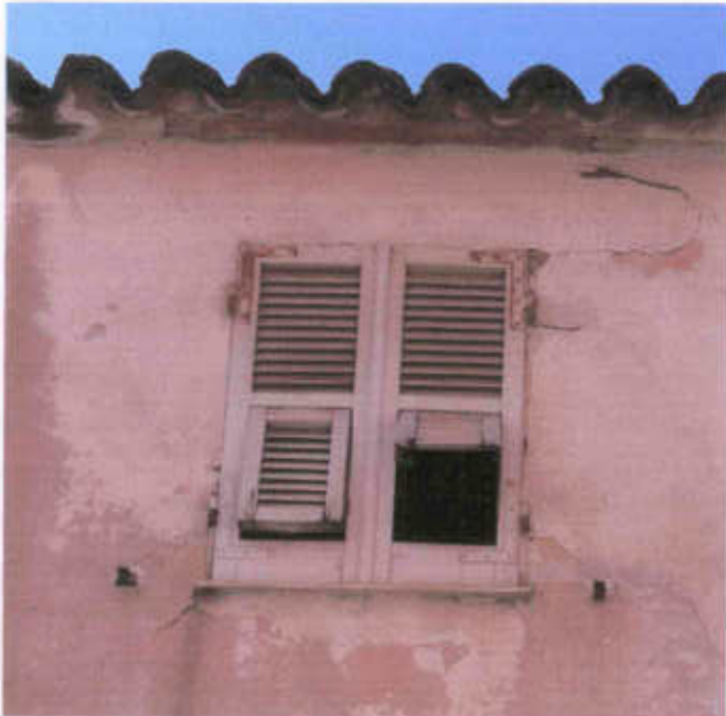
FINESTRA AL PIANO PRIMO 😊
